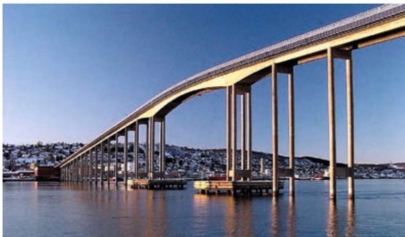
Автодорожный мост соединяет материковую и островную части Тромсё Motor road bridge connects continental and island parts of Tromsø
